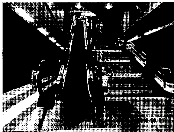
依據鐵工局鐵路車站旅運與站務設施設計注意事項，提供友善搭乘環境之電扶梯。
