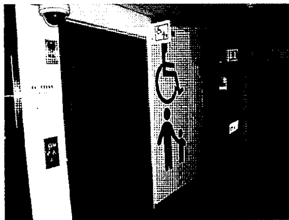
依據本局機電工程設計注意事項於廁所及哺乳室門設置閉路電視攝影機。
